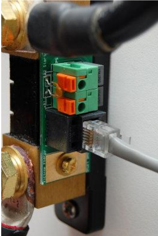
afb. 11 UTP kabel aansluiten
